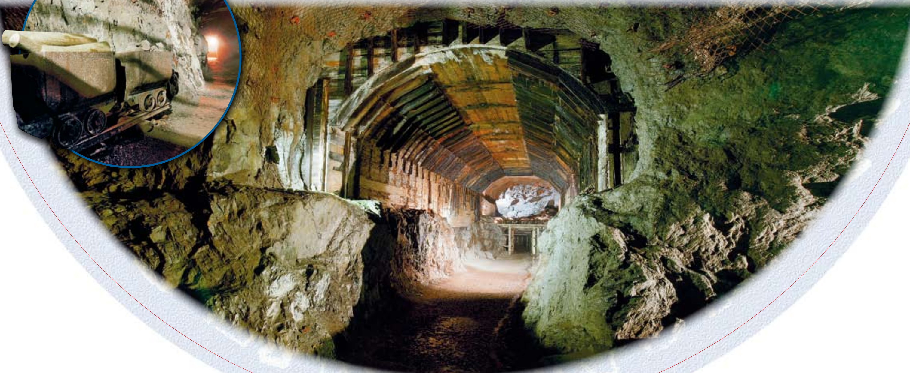
Podzemní město Osówka, Gluszyca / Podziemne Miasto Osówka, Gluszyca
