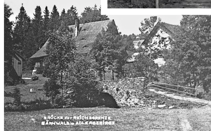
Podoba mostu z 19. století / Wygląd mostu w XIX wieku
