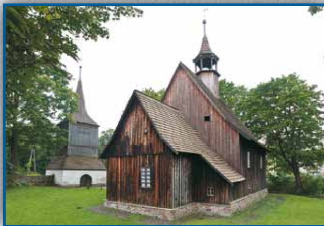
Dřevěný kostelík v Rybnici Lešnej
