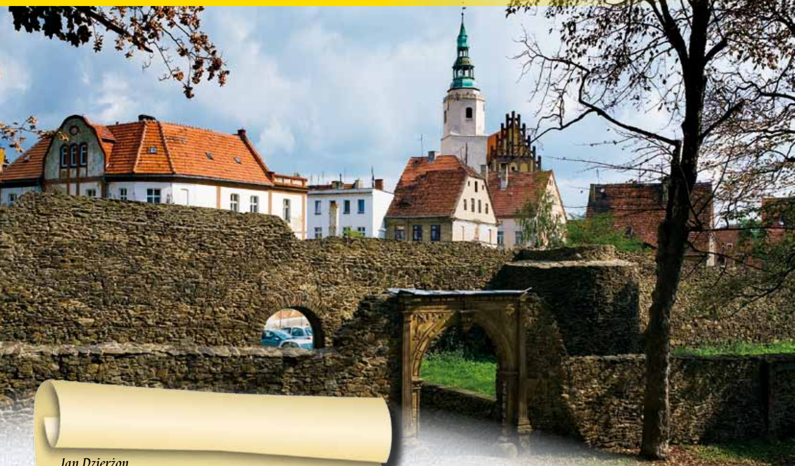
Pozostałości murów miejskich w Dzierżonowie
