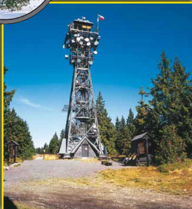
2 Wieża telekomunikacyjna oraz wieża widokowa na Czarnej Górze.
