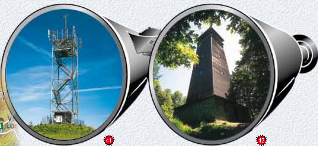
Telekomunikační věž na vrcholu Val a dřevěná rozhledna na vrcholu Háj.
