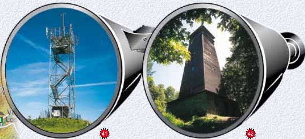
Wieża telekomunikacyjna na szczycie Val oraz drewniana wieża widokowa na wzniesieniu Háj.
