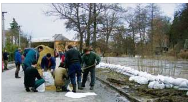
Budování protipovodňových zábran v roce 2006
