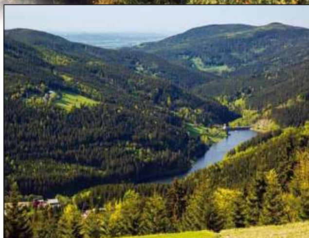
Vodní nádrž Labská nedaleko Špindlerova Mlýna
