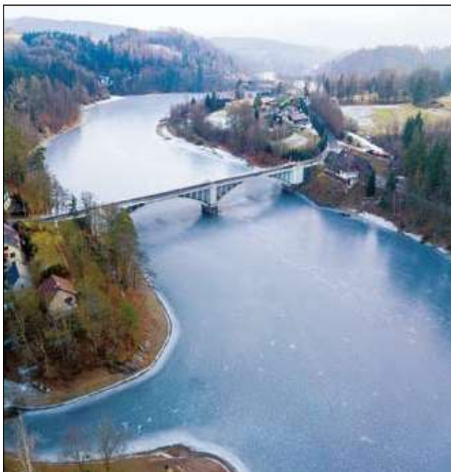
Železobetonový most přes přehradní nádrž Pastviny
