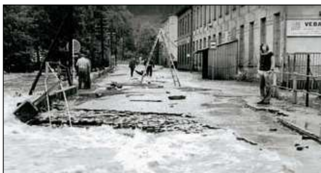
Stržený most ve Velkých Petrovicích po povodni na Metuji - rok 1979
