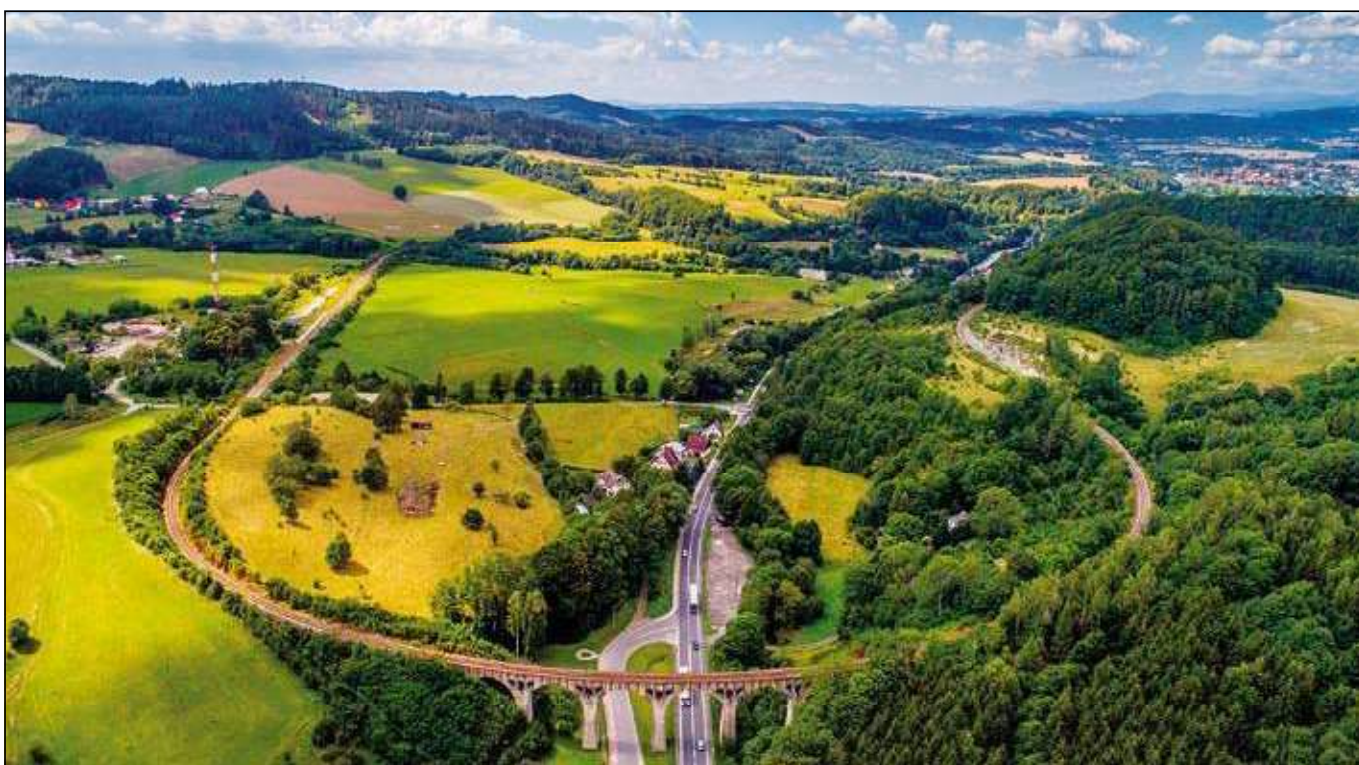
Železniční viadukt v obci Lewin Kłodzki
