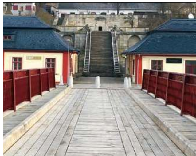
Stalowa część wyremontowanego mostu w miejscowości Kuks
