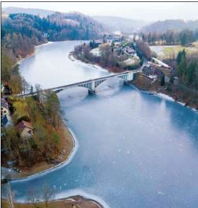
Żelbetowy most przez zaporę Pastviny
