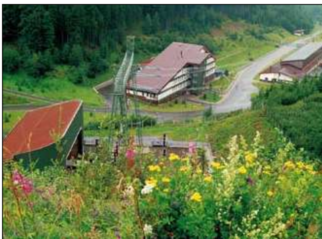
Stacja transformatorowa przy dolnym zbiorniku
