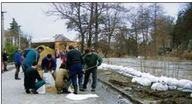
Budowanie barier przeciwpowodziowych w 2006 roku
