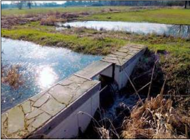
Zastawa na odnowionych kanałach
