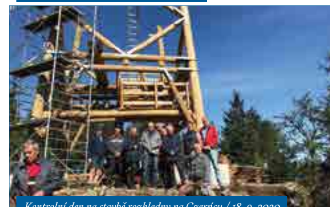
Kontrolní den na stavbě rozhledny na Czernícu / 18. 9. 2020
