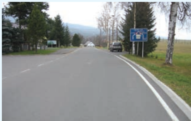
Orlické Záhoří – Modernizacja drogi II/311
