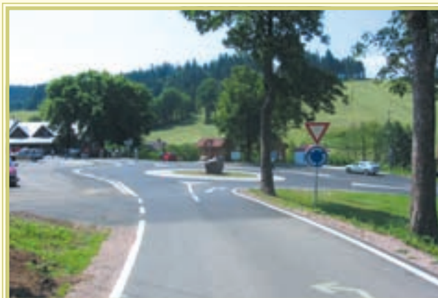
Modernizacja dróg w powiecie Ústí nad Orlicí
