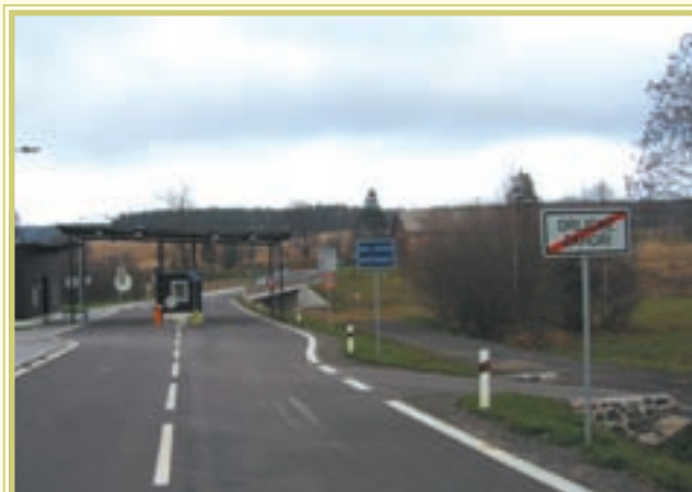
Przejście drogowe Mostowice - Orlické Záhvoří
