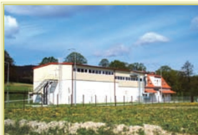
Oczyszczalnia ścieków w Międzyzlesiu
