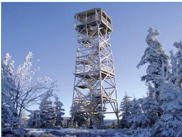
Budowa wieży widokowo – przeciwpożarowej na Trójmorskim Wierchu
