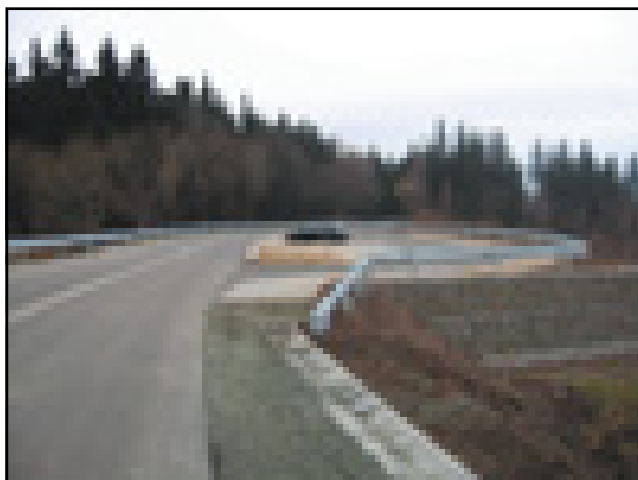
Modernizacja drogi nr 389 Duszniki Zdrój – Zieleniec
